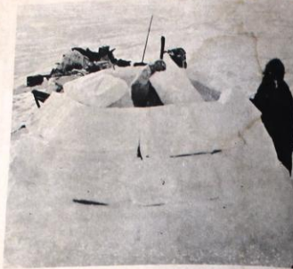
Figura 18-5 Construcción de un Iglú
