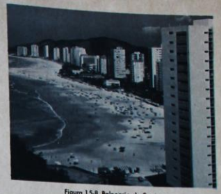
Figura 15-8 Baieiro de Santos
