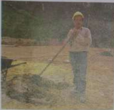
Obrero de la construcción.
