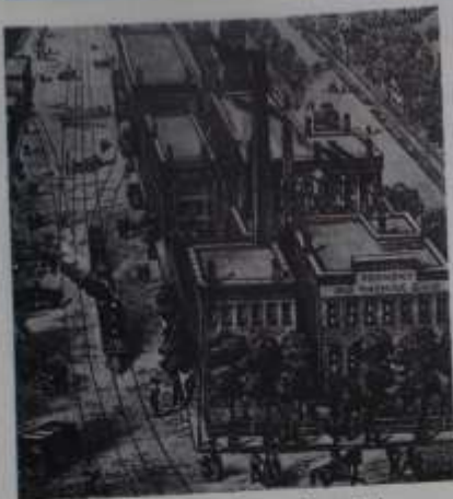
Instalaciones industriales en Oswego, Nueva York.
