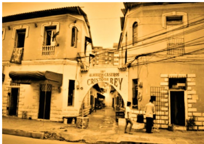
Figura 13: Pasajes del barrio Abajo. Esta vivienda colectiva, patrimonio histórico de la ciudad fue demolida por la administración municipal. Los Pasajes fueron sitios muy concurridos, lo que hizo de ellos focos de tuberculosis.
